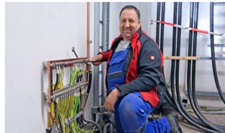
Die Arbeiten im Umspannwerk West haben im ersten Quartal begonnen.
