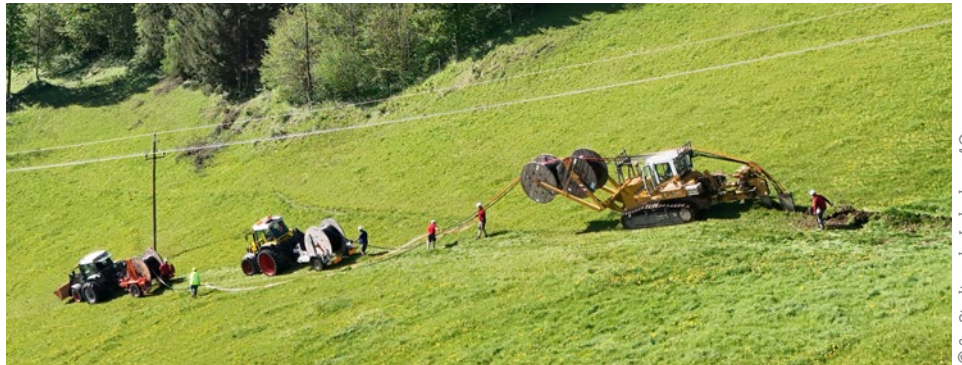
Erdverkabelung in Eppenstein
