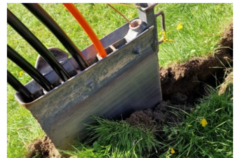
Kabelpflügen – wenig Eingriff in den Boden
