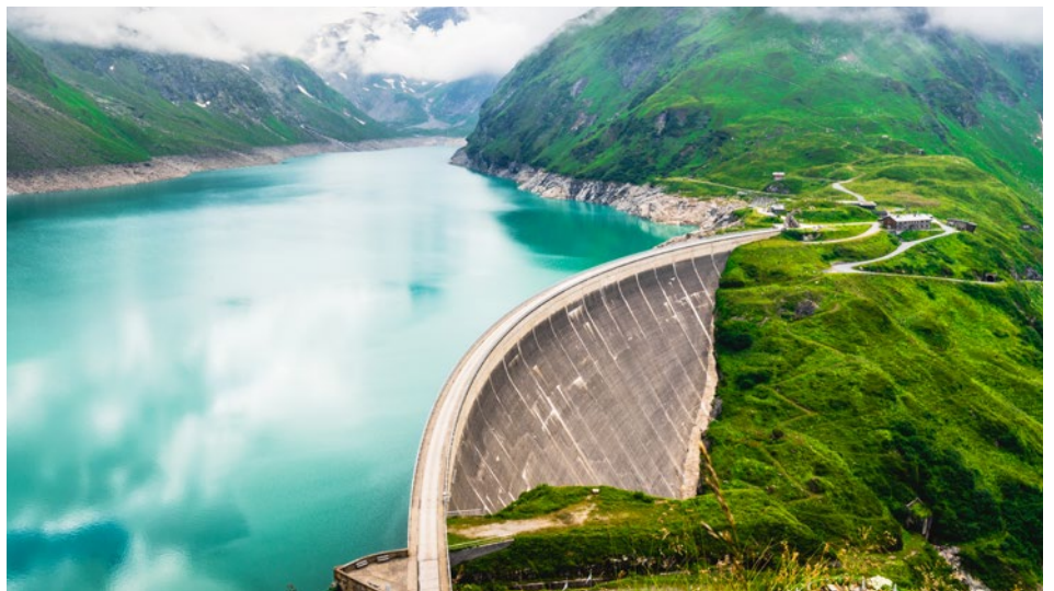
Pumpspeicherkraftwerke – wie hier in Kaprun – sind sehr gut geeignet, um die witterungsbedingt schwankenden Erzeugungsmengen von Solar- und Windkraftwerken auszugleichen.
