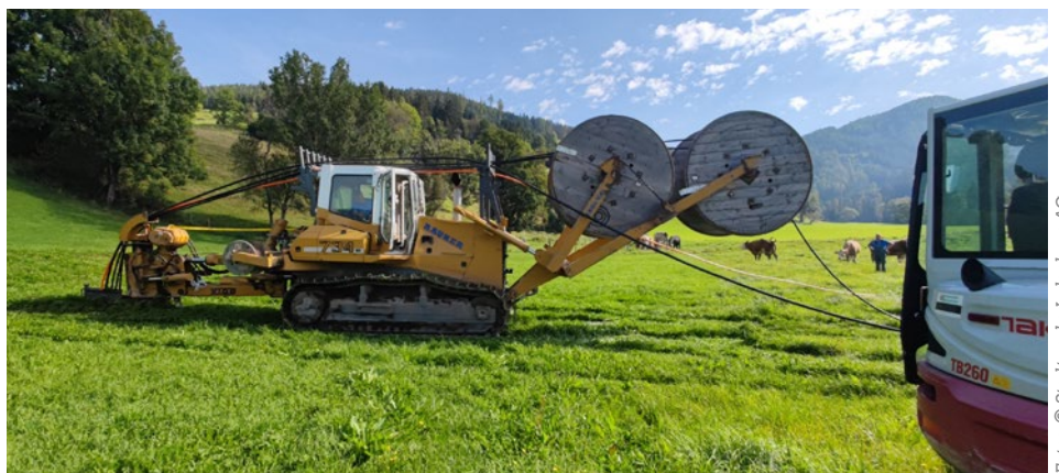
Der moderne Kabelflug macht's möglich: Schonende und schnelle Verlegung des 20 kV-Kabels
